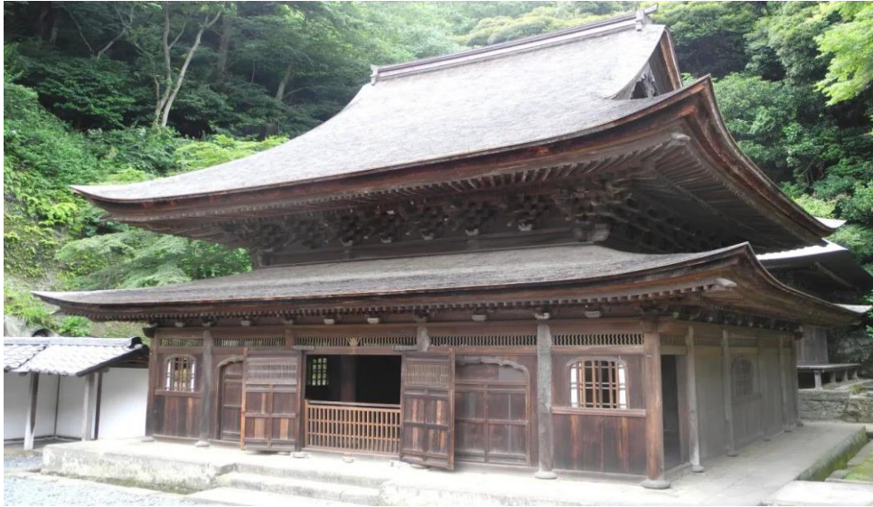
图 17 圆觉寺舍利殿外观 14 世纪初期，日本镰仓
