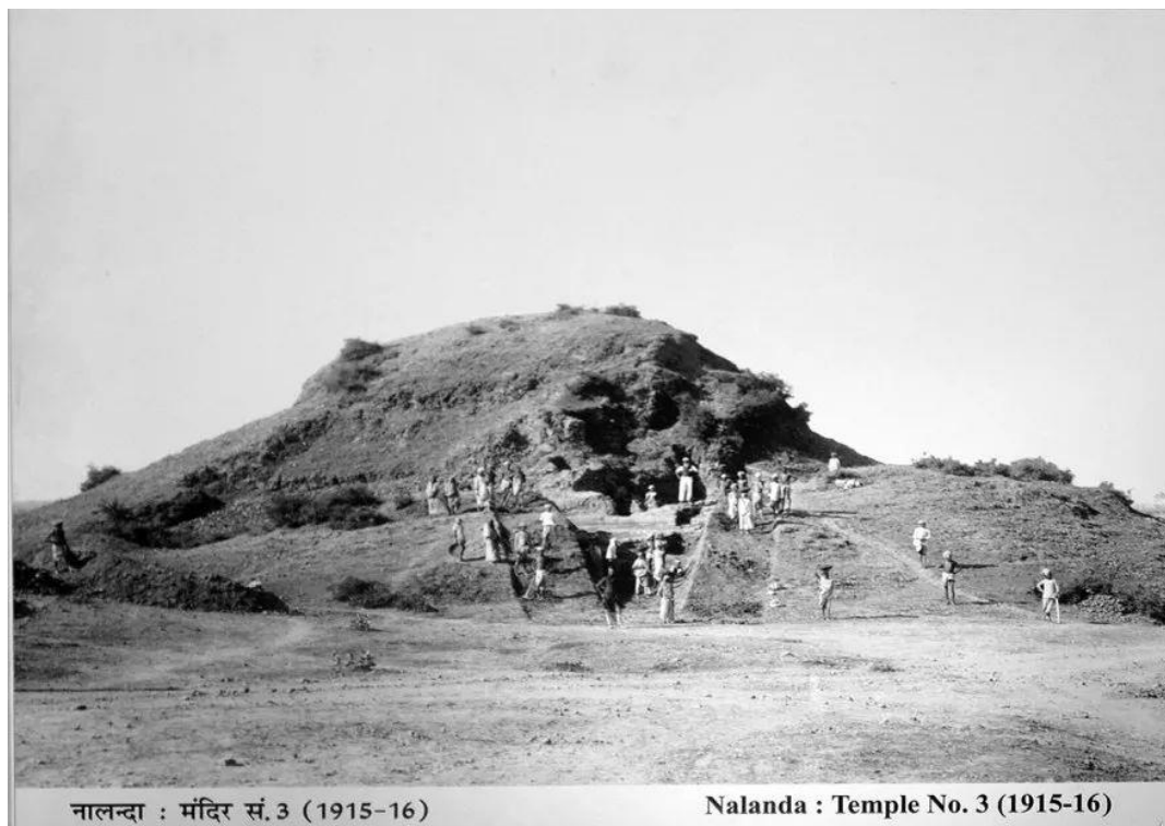
(图 4) 那烂陀 3 号遗址挖掘前 拍摄于 1915-16 年
